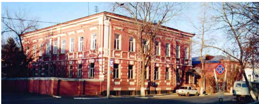
Здание ОКВД на ул. Кобозева, 39 (2005 г.)
